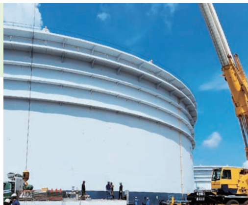
システム機工の大型タンク洗浄作業の様子
