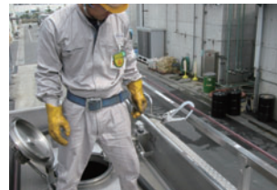
格納式安全带取付バーの設置(関西事業所)
