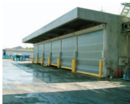
臭気対策 汚泥置場シャッター (名古屋事業所)
