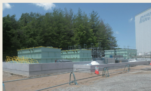
建設中の広島事業所
