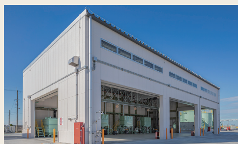
播磨リサイクルセンターの補助燃料工場
