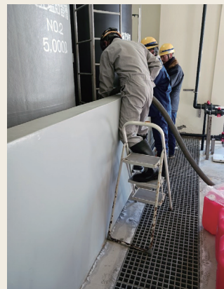
能登半島地震の復旧支援の様子
